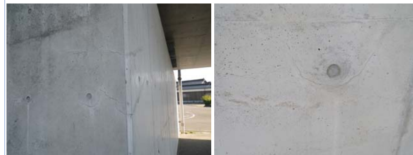
システム運用前 : 橋台(寄江高架橋H10)
