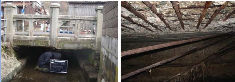
橋梁側面全景
