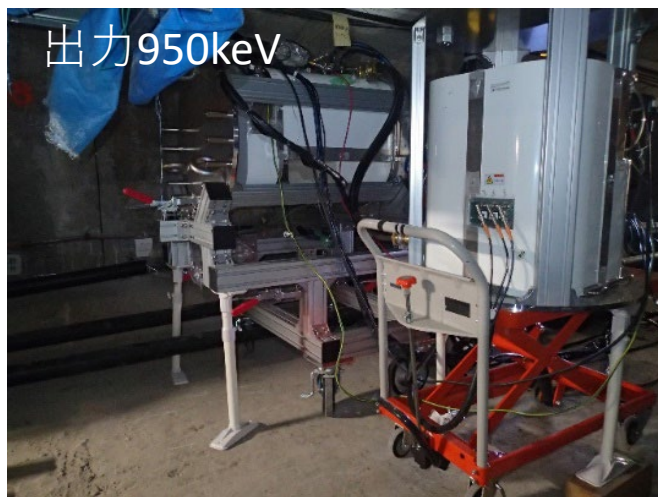
(妙高大橋桁内, 2015年)
