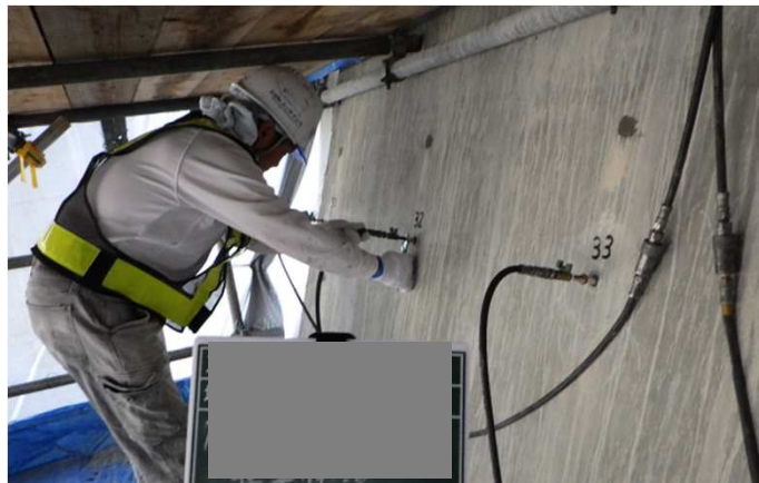
加圧パッカー装着工
