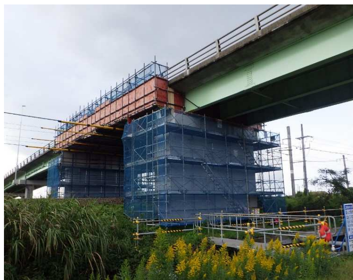
交差条件によりアプローチ困難 (跨線橋)
