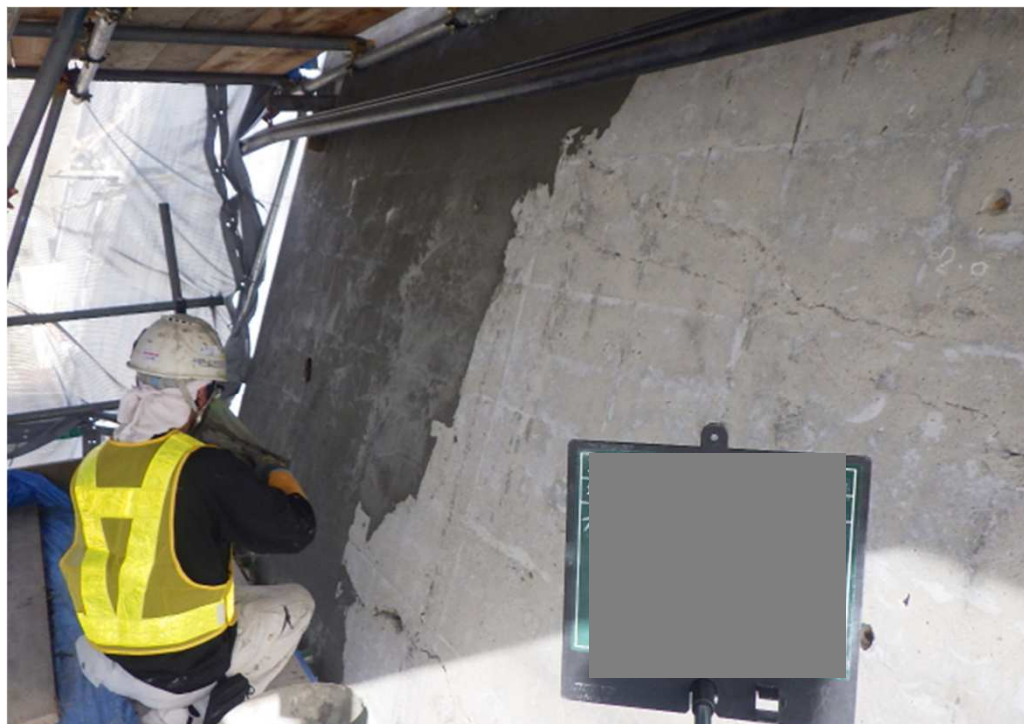
ポリマーセメントモルタル塗装状況
