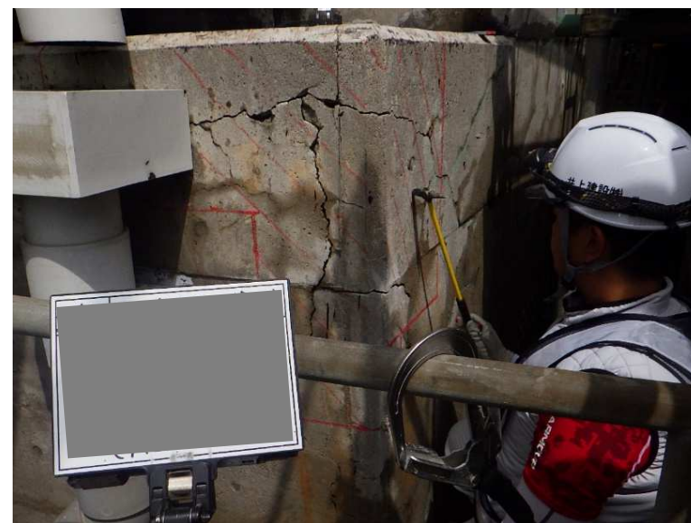
コンクリートの剥離欠損箇所の調査
