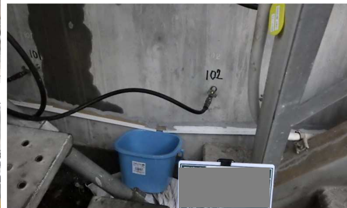
廃液処理対策 樋設置
