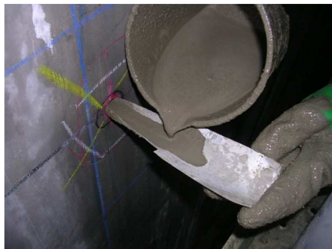
無収縮グラウト充填状況
