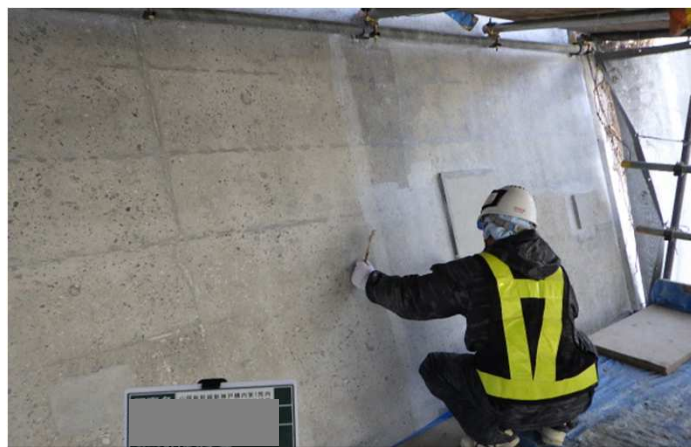
高分子浸透性防水材料塗布
